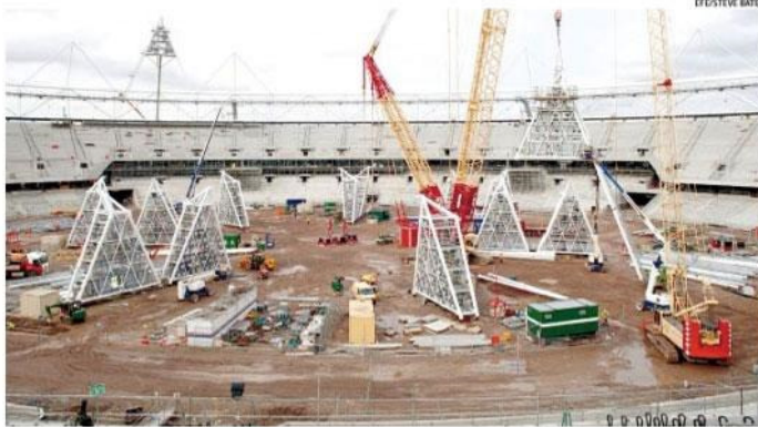
Máquinas começam instalação das torres de iluminação do Estádio Olímpico de Londres (GBR), palco dos Jogos de 2012
